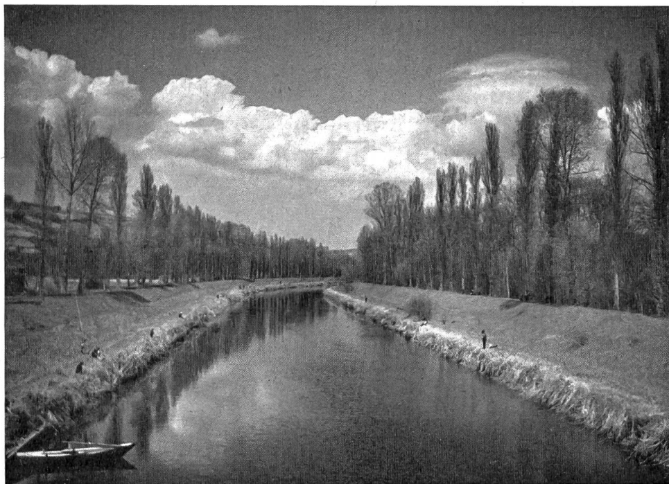
Abb. 1 Broyekanal, die Verbindung Murtensee—Neuenburgersee (Photo J. Gaberell AG, Thalwil)
