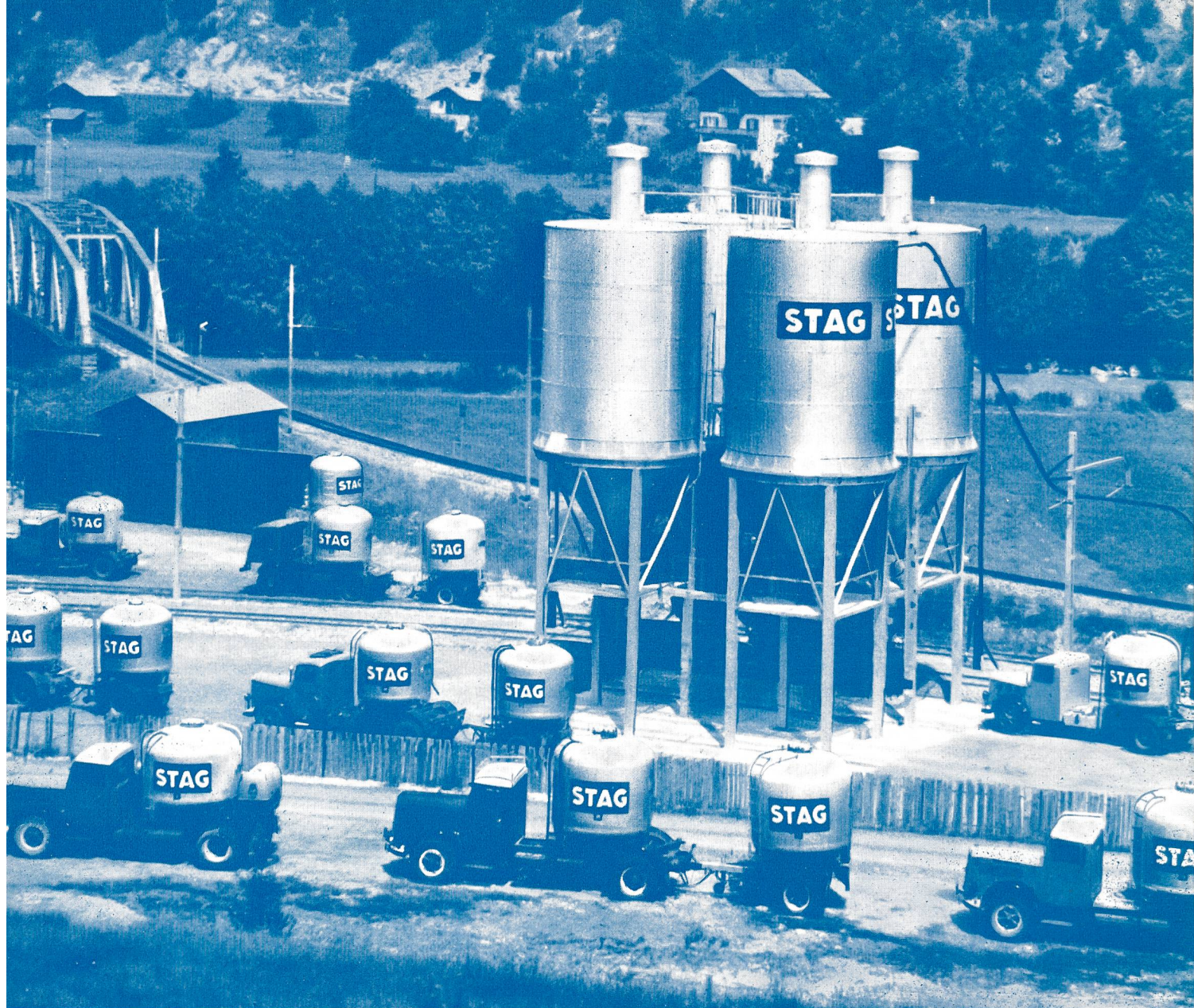
Umschlagsanlage Illanz der STAG: 4 Silos mit total ca. 800 t Fassungsvermögen
