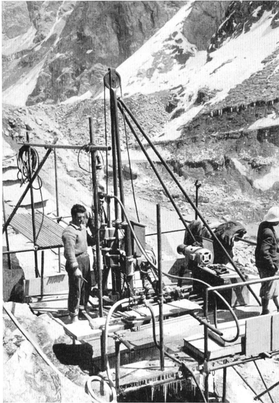
Bohrungen Staumauer Moiry
