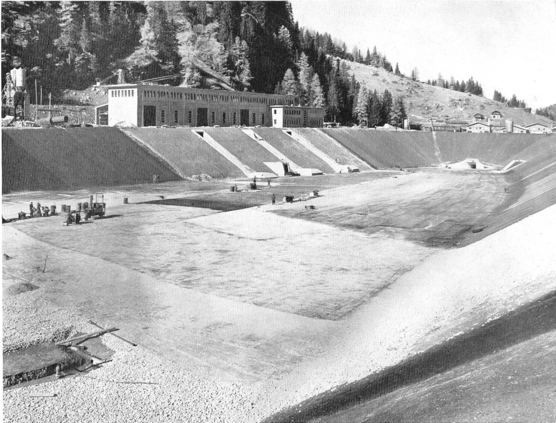
Ausgleichbecken Mottec der Kraftwerke Gouggra AG
