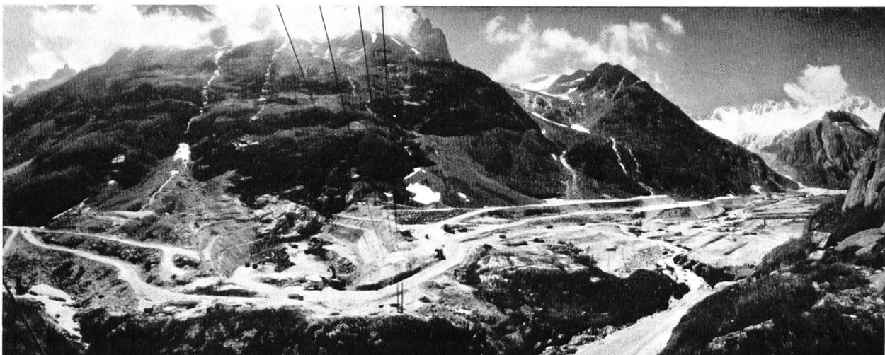
Bild 9 STAUDAMM GÖSCHENERALP\* (Photo vom 24. Juli 1956). Ausgedehnte Baustelle der Kraftwerk Göschenen AG, Göschenen, auf der Göschenalp für den Bau eines Steindammes (rock-fill) zwecks Schaffung des Stausees Göschenalp von 75 Mio m<sup>3</sup> bzw. 195 Mio kWh nutzbarem Energieinhalt; größte Höhe des Steindammes 155 m, Länge auf Kronenhöhe 540 m, voraussichtliche Dammkubatur rund 8,7 Mio m<sup>3</sup>. Bauperiode 1955/61.
