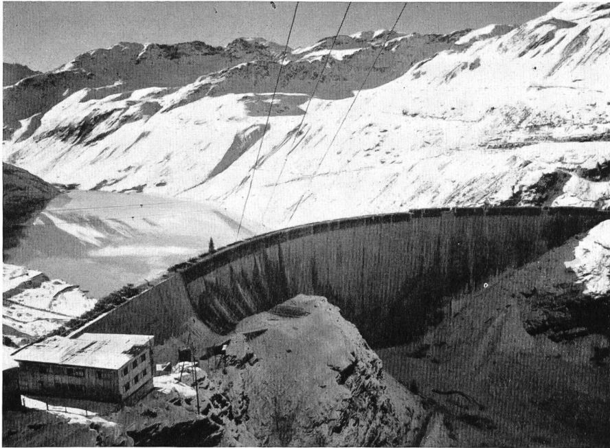
Bild 5 STAUMAUER MOIRY* der Forces Motrices de la Gougra S. A., Sierre, für den Lac de Moiry von 72 Mio m 3 bzw. 256 Mio kWh nutzbarem Speicherinhalt; Stauziel 2246 m ü. M.; Gewölbestaumauer in Beton; größte Höhe über Fundament 145 m, Länge auf Kronenhöhe 610 m. Beginn der Installationsarbeiten: Mai 1954, Beginn der Betonierarbeiten: Mai 1956, Beendigung der Betonierarbeiten: November 1957, totale Staumauerkubatur: rund 810 000 m 3 ; Betonier-Spitzenleistungen: pro Tag 4670 m 3 (Juli 1957), pro Monat rund 103 000 m 3 (Juli 1957). Höchster Personalbestand bei der Staumauer: 469 Arbeiter und 91 Angestellte (Juli 1957).
