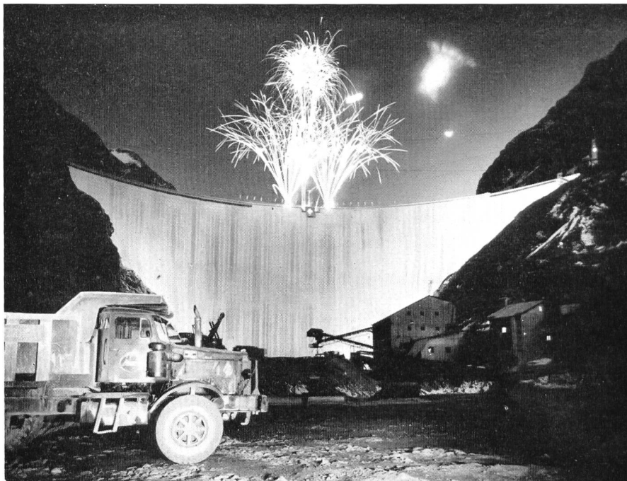
Bild 7 STAUMAUER MAUVOISIN * mit Feuerwerk anlässlich der Feier zur Fertigstellung der Staumauer am 31. Oktober 1957 (Photo R. Dorsaz, Martigny-Ville); Anlage der Forces Motrices de Mauvoisin S. A., Sion, für den Stausee Mauvoisin von 180 Mio m 3 bzw. 585 Mio kWh nutzbarem Speichereinhalte, Stauziel 1961 m ü. M., Gewölbestaumauer in Beton; größte Höhe über Fundament 237 m (höchste Bogenstaumauer der Welt), Länge auf Kronenhöhe 520 m. Beginn der Installationsarbeiten 1951, Beginn der Betonierarbeiten Ende 1954, Beendigung der Betonierarbeiten Ende Oktober 1957, totale Staumauer-Kubatur 2 020 000 m 3 . Betonier-Spitzenleistungen: pro Tag 8037 m 3 , pro Woche 41 112 m 3 (22./27. Juli 1957), pro Monat 172 742 m 3 (Juli 1957). Durchgehende Wasserkühlung mittels etwa 330 000 m Spezialrohr \phi 22/19,5 mm; Fugendichtung mit etwa 4000 m Kunstgummiband auf der Wasserseite und etwa 21 000 m Plasticband in den übrigen Fugen; mittlere Zementdosierung 207 kg/m 3 ; Totalverbrauch 420 000 Tonnen Portlandzement; erstmalige Verwendung von Bulldozern für Einbringen von Massenbeton mit vollautomatischer Vibration; Beimischung von 130 000 kg Luftporenzusatzmittel zur Qualitätsverbesserung des Betons.
