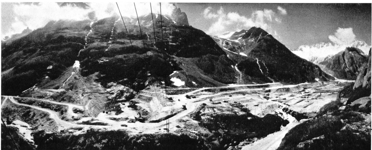
Bild 9 STAUDAMM GÖSCHENERALP* (Photo vom 24. Juli 1956). Ausgedehnte Baustelle der Kraftwerk Göschenen AG, Göschenen, auf der Göschenentalp für den Bau eines Steindammes (rock-fill) zwecks Schaffung des Stausees Göschenentalp von 75 Mio m 3 bzw. 195 Mio kWh nutzbarem Energieinhalt; größte Höhe des Steindammes 155 m, Länge auf Kronenhöhe 540 m, voraussichtliche Dammkubatur rund 8,7 Mio m 3 . Bauperiode 1955/61.
