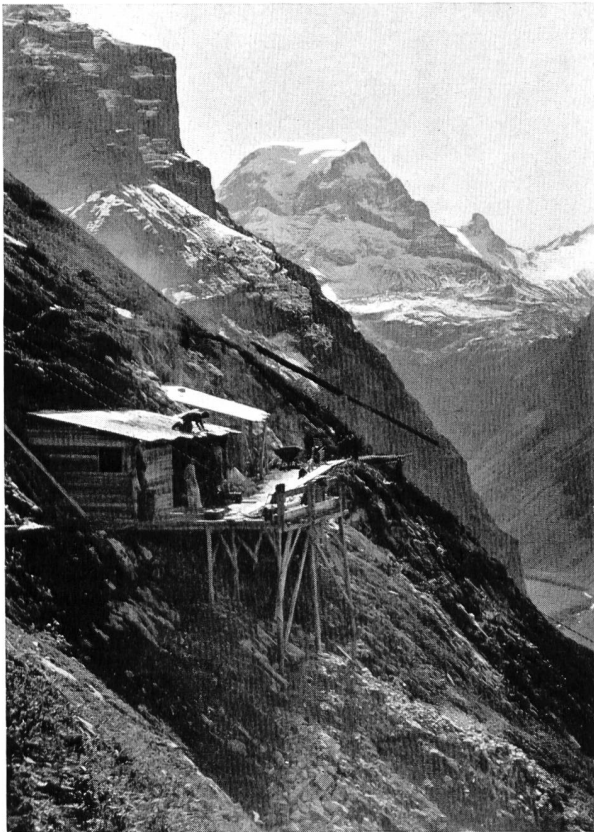
Bild 13 Bergstation «Kalktrittli» oberhalb der Baumgartenalp, Installationsrampe bei der Bauseilbahn — Kaverne mit Baracken für Werkstätte, Kompressoren, Notstromaggregat und Unterkunft. Im Hintergrund der Tödi, 3620 m ü. M.
