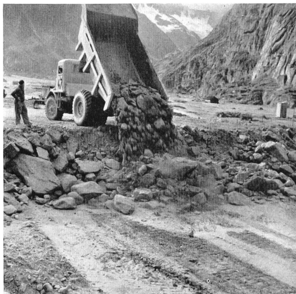
Bild 6 Versuchsfeld Nr. 2: Naßschüttung. Das Transportfahrzeug fährt bis an die Böschungskante, damit der Kollerweg des Materials möglichst kurz wird. Schütthöhe 2 m.
