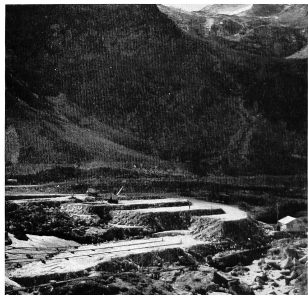
Bild 4 Übersicht über die Versuchsschüttung Im Vordergrund: Schüttung mit Einspülen. Bild-Mitte: Aushub einer Versuchsrube zur Bestimmung des Raumgewichtes.
