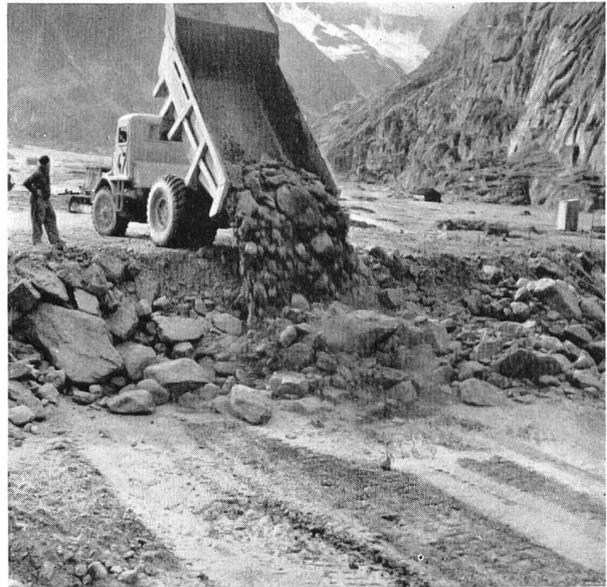
Bild 6 Versuchsfeld Nr. 2: Naßschüttung. Das Transportfahrzeug fährt bis an die Böschungskante, damit der Kollerweg des Materials möglichst kurz wird. Schütthöhe 2 m.
