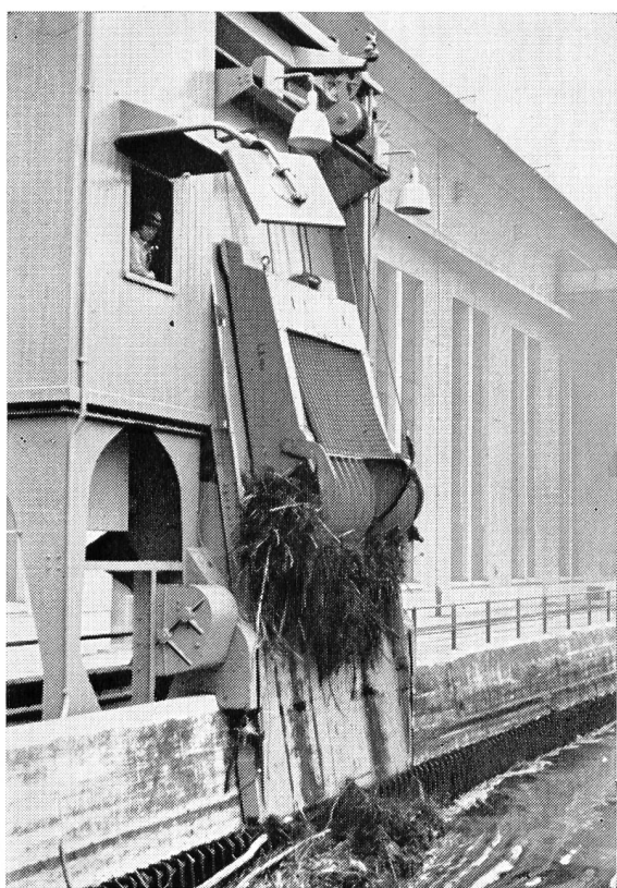
Maschine während dem Reinigen
