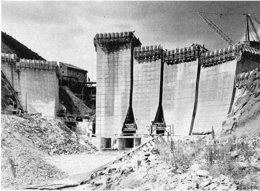
Fig. 99 Le barrage, en état de construction, de l'usine de Jablanica (hauteur H = 80 m, hauteur d'eau 70 m), déjà terminé et en exploitation. C'est le plus haut barrage en Yougoslavie.
