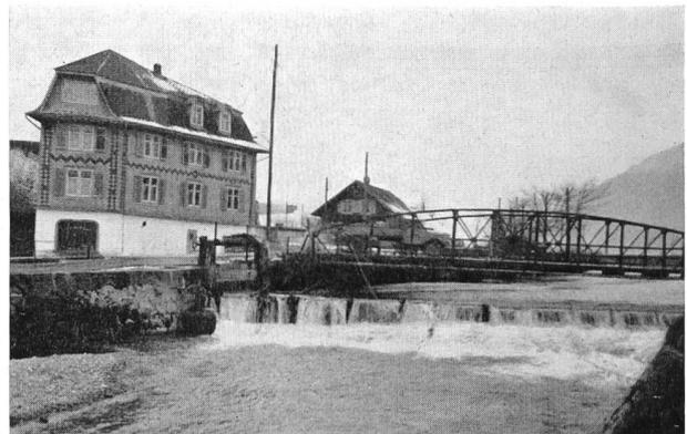
Bild 9 Engelbergeraas bei Buochs, Nidwalden, mit unhaltbaren Abflußverhältnissen: zu tief liegende Brücke und zu hoch stauendes unbewegliches Wehr für eine Wasserfassung (Dezember 1950)
