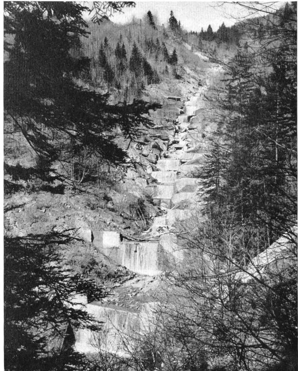
Bild 13 Mettenlaur bei Giswil. Die Sperrentreppe ist teilweise durch Seitendruck zerstört, als Folge tiefgründiger Rutschungen im rechten Hang (1958)
