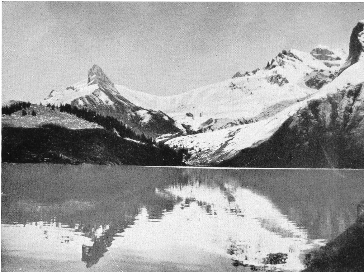
Bild 2 Bannalpsee des Kantonalen Elektrizitätswerkes Nidwalden
