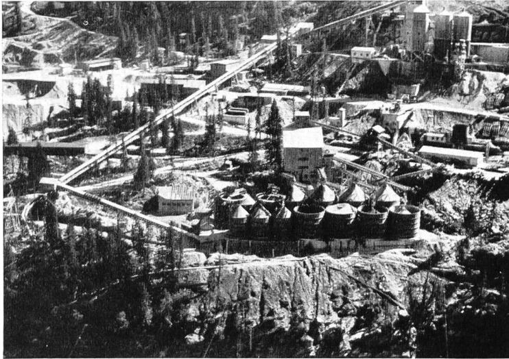
Kiesaufbereitungsanlage im Kraftwerk Zervreila mit Förderbandanlage aus verleimten Holzfachwerkträgern, System Kämpf, in einer Gesamtlänge von über 300 m und Stützweiten von ca. 30 m
