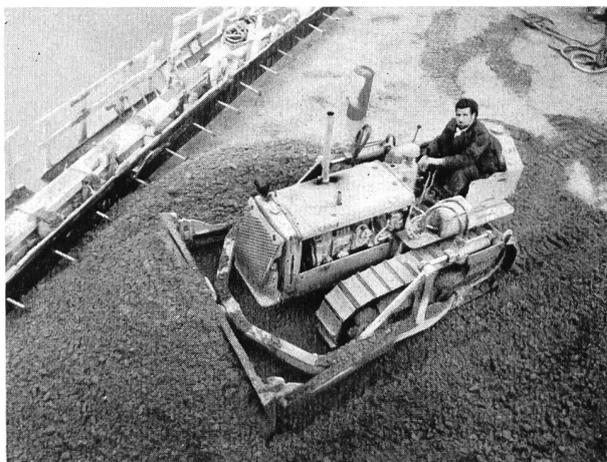
Bild 6 Ausbreiten des Betons (Zeuzier/Lienne)
