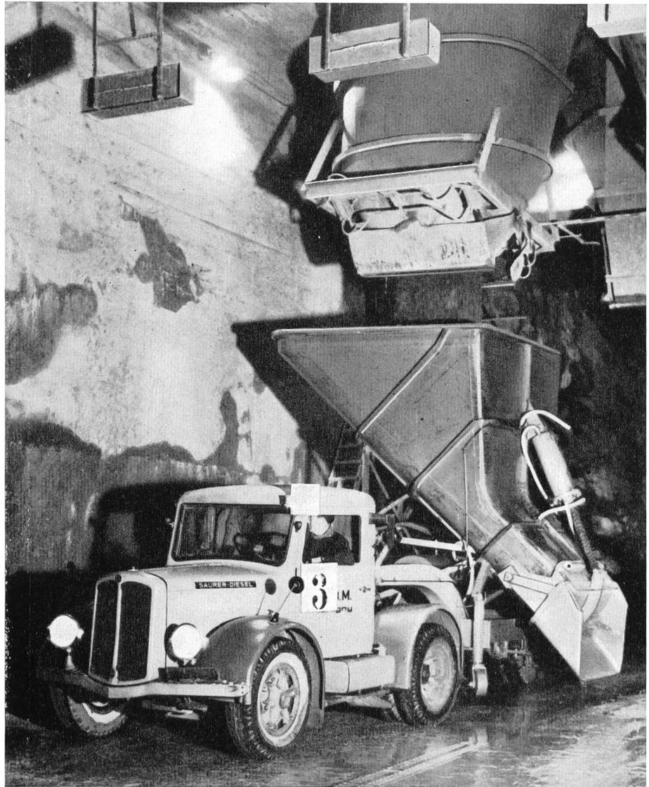
Bei den großen Kraftwerksbauten im Wallis wird der Beton vom Mischer weg in Betonschleppern an die Baustelle transportiert. SAURER baut Sattelschlepper mit sehr kurzem Radstand, welche äußerst wendig sind und dank des Dieselmotors sehr ökonomisch arbeiten. Ein großer Luftkompressor sorgt für den pneumatischen Antrieb der Betonablaßvorrichtung.
