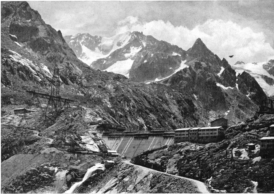
Bild 1 Staumauer Albigna; Blick auf Cima dal Cantun und Punta d'Albigna
