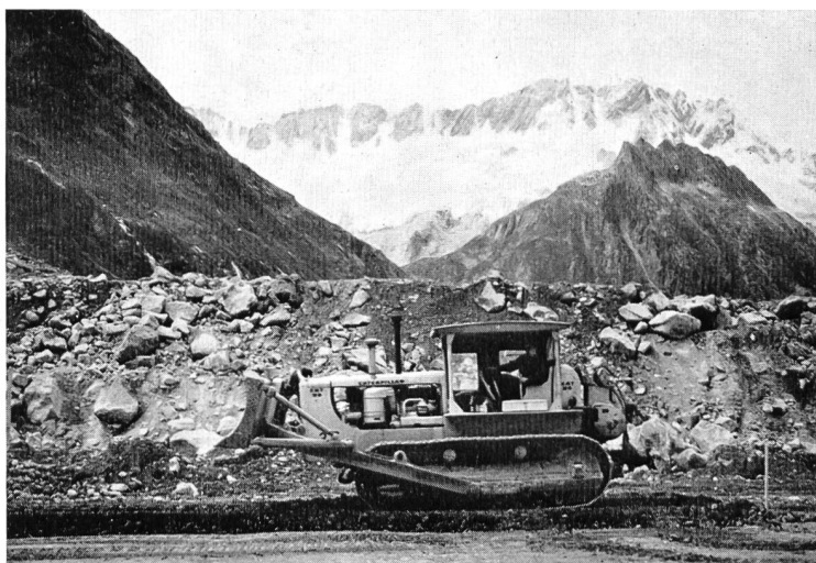
Einwalzen des Kernmaterials für den Staudamm auf der Göschenernalp; Blick auf Rhonestock und Dammastock
