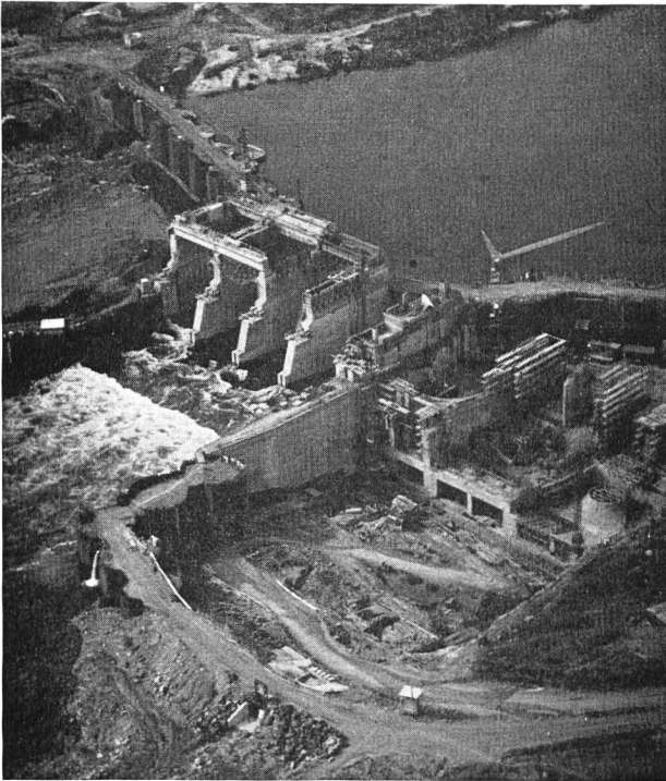
Bild 6 Flugaufnahme der Baustelle Baygorria vom Juli 1958
