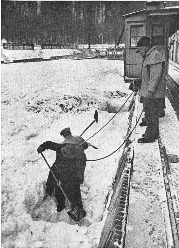
Bild 6 Rechen-Enteisung beim Kraftwerk Ruppoldingen (Photo ATEL)
