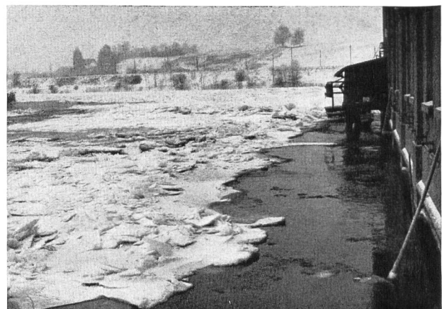
Bild 5 Überschwemmte Rechenbrücke des rechtsufrigen Werkes der Kraftwerke Wynau (Photo K. Achermann)
