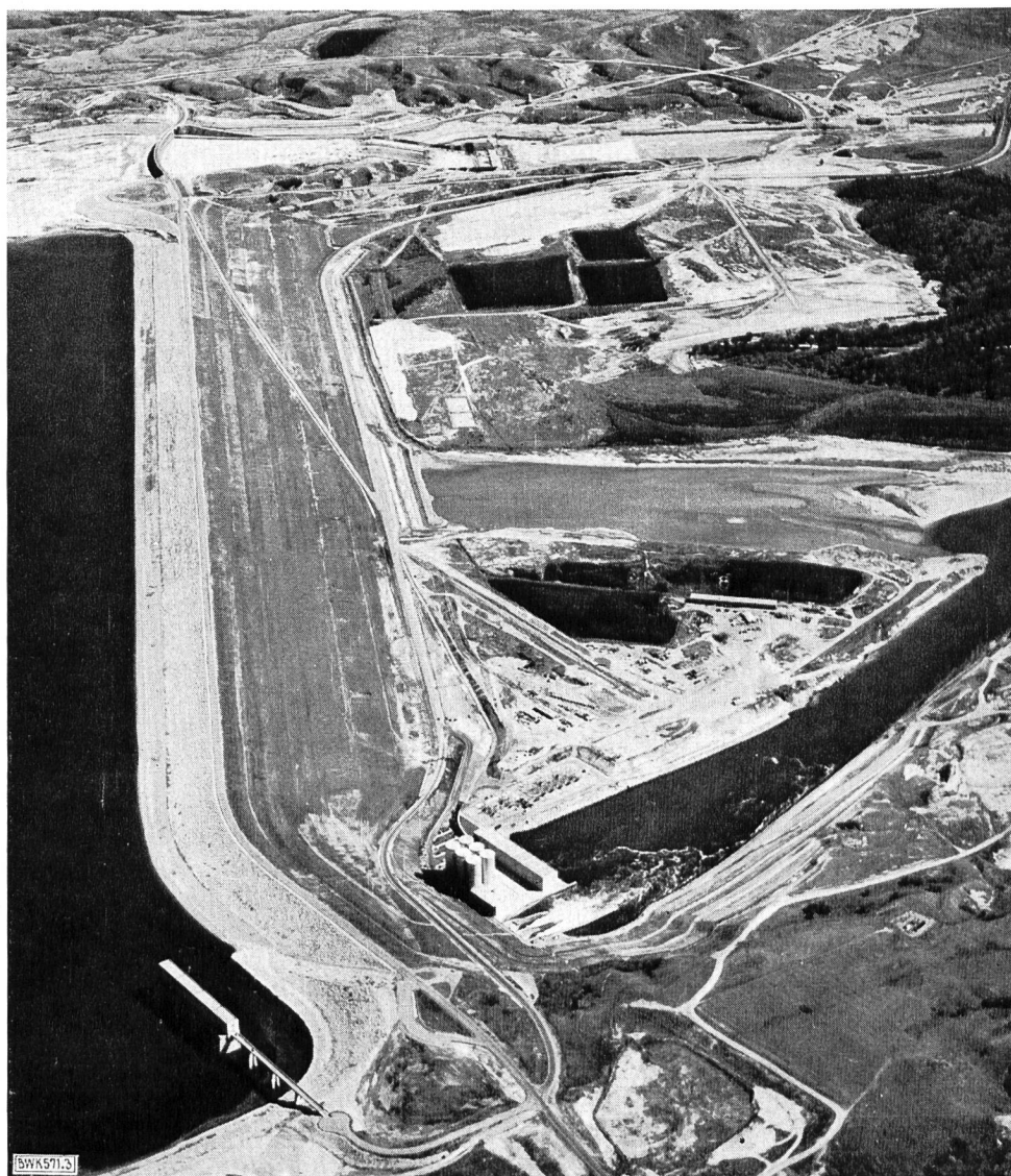
Bild 4 Luftbild der Stauanlage Garrison Dam in Nord-Dakota. Unten links das Einlaufgebäude, rechts Wasserschloß, Kraftwerk und Grundablässe; am andern Ende des Erddammes das 440 m lange Überfallbauwerk
