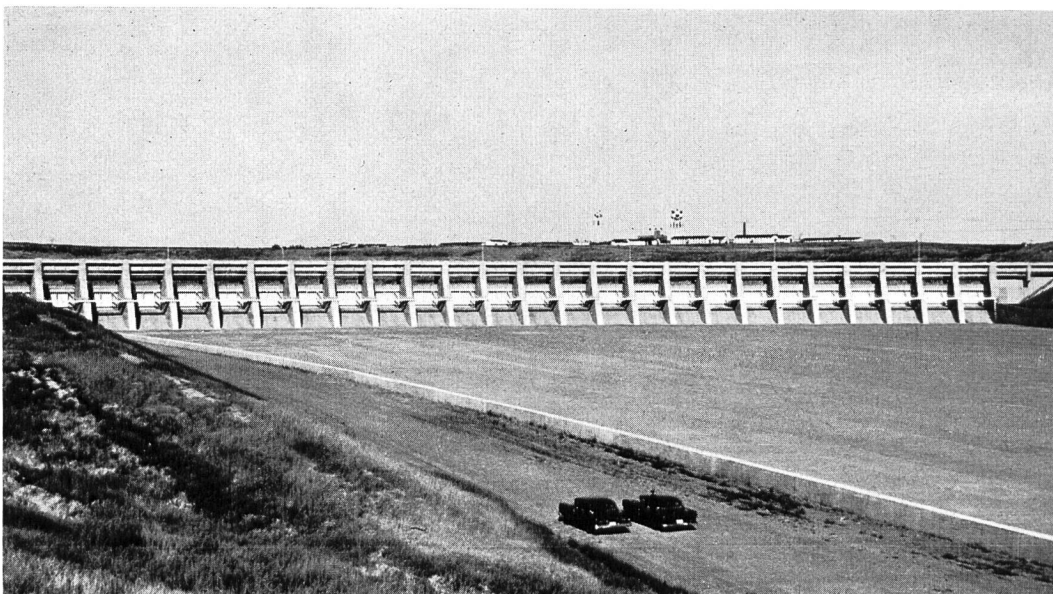
Bild 3 Garrison-Kraftwerk: Anlage für die Hochwasserentlastung
