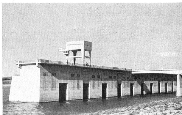
Bild 9 Fort Randall-Kraftwerk: Einlaufbauwerk mit Bedienungskran der Abschlussschützen
