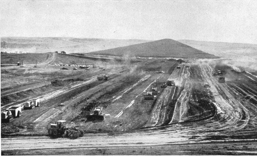
Bild 5 Oahe-Kraftwerk: Blick auf den Staudamm beim Einbau des Dichtungskernes
