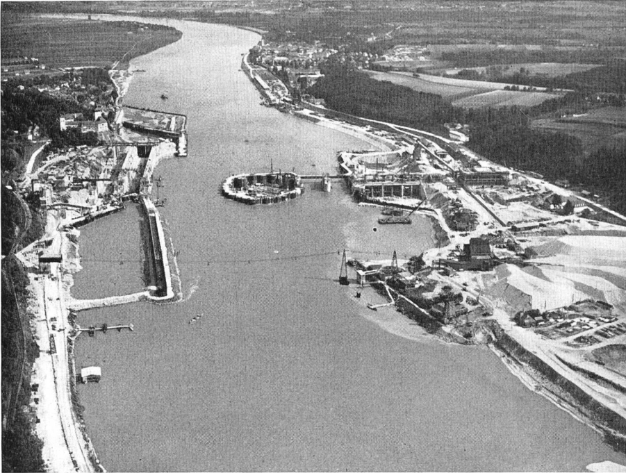
Bild 13 Baustellenübersicht, Bauzustand II (Aufnahme vom 3. August 1956)
