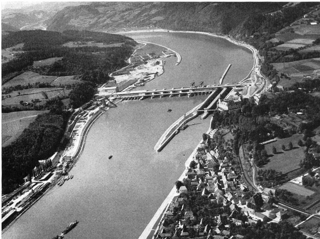
Bild 25 Die fertiggestellte Donaustufe Ybbs-Persenbeug (Aufnahme vom 15. September 1958)
