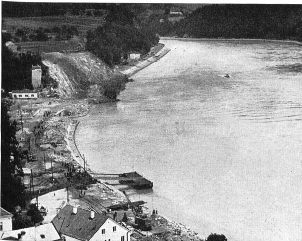
Bild 24 Das Schwallleck nach Sprengung des Felswalls
