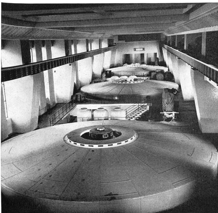
Bild 16 Blick in das Südkraftwerk
