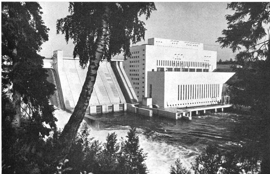
Bild 11 Wasserkraftanlage Pyhäkoski am Oulujoki (Bruttogefälle 32,3 m, 120 MW, 610 GWh) der Oulujoki Oy, seit 1949/1951 in Betrieb (Photo Roos, Helsinki)
