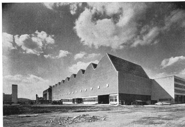
Bild 2 Blick auf die große Montagehalle, gesehen von der Hauptzufahrt zum Fabrikgelände
