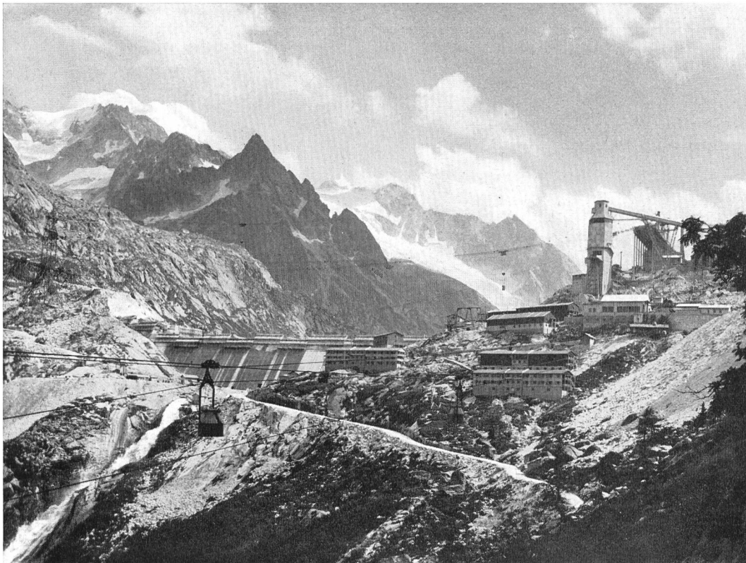
Bild 1 Staumauer Albigna mit Betonfabrik, Baukantine und Unterküften; im Hintergrund, von links, Cima dal Cantun, Punta da l'Albigna, Cima di Castello (Photo U. Beyeler, Basel)
