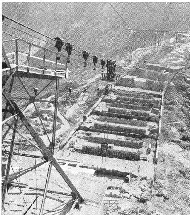
Bild 7 Betonierungsvorgang auf Albigna, Aufnahme vom 28. August 1958 (Photo H. Bickel, Zürich)
