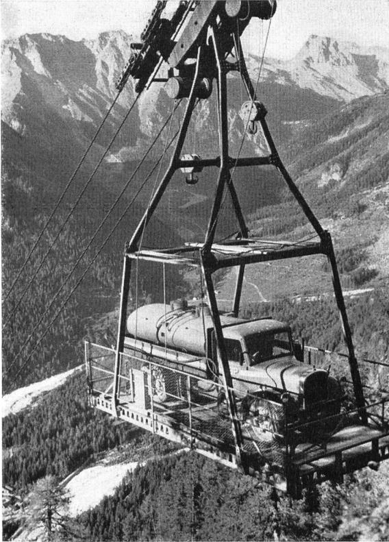
Bild 21 Schwerkabelbahn auf der Fahrt mit Öl-Camion
