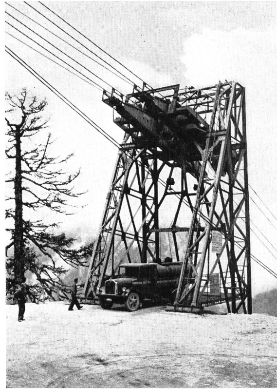
Bild 22 Ausfahrt des Camions in der Bergstation (Photo Rutz, St. Moritz)
