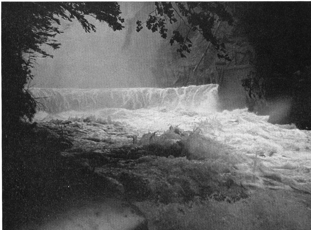
Destruction d'énergie par la formation artificielle d'un seuil Tempérament et volonté — Energie et épreuve (Châtelot, Photo Electrowatt)
