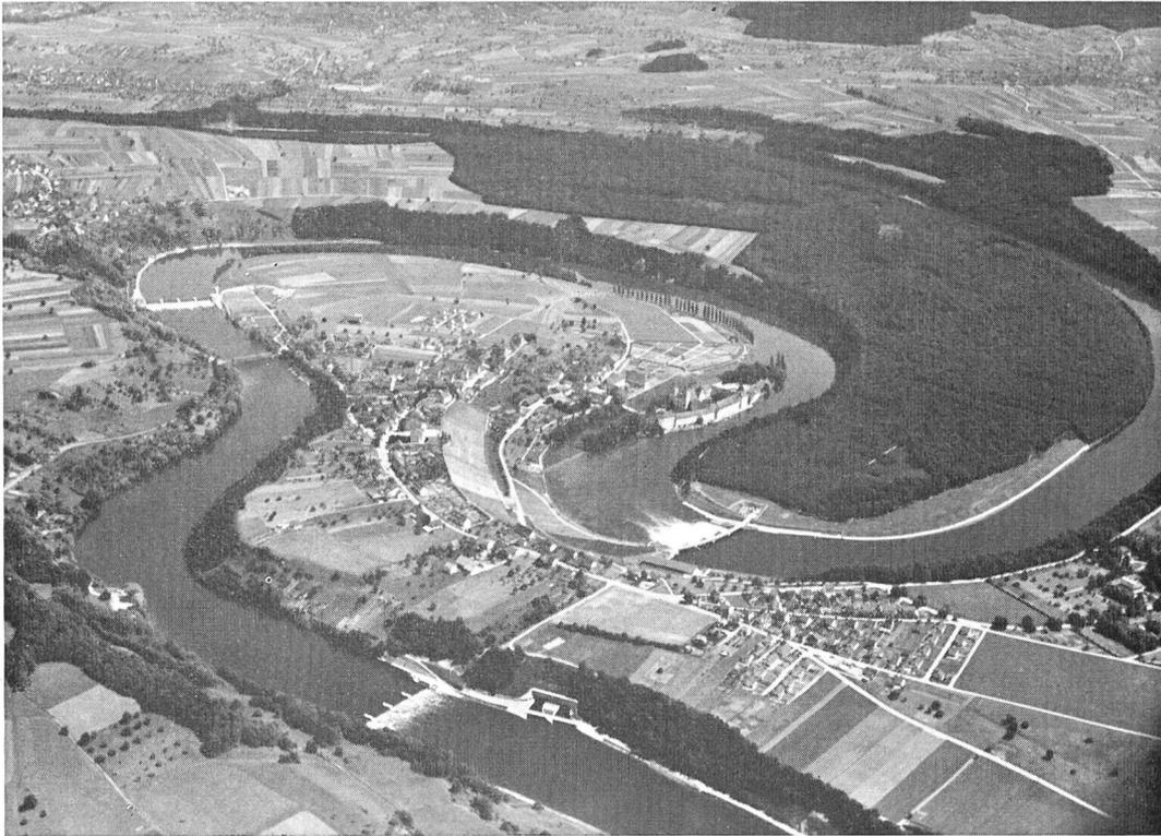
Bild 13 Grenzkraftwerk Rheinau mit Rheinschleife (Inbetriebnahme 1956). Rechts Hauptstauwehr mit Überlauf zur Dotierung der durch die Kraftnutzung abgeschnittenen Rheinschleife (der Auslauf des Unterwasserstollens des Kraftwerkes ist im Vordergrund sichtbar). Die beiden Hilfswehre (links) sorgen für die gewünschte Wasserhaltung im abgeschnittenen Flußarm. (Fliegeraufnahme Swissair AG, Zürich)
