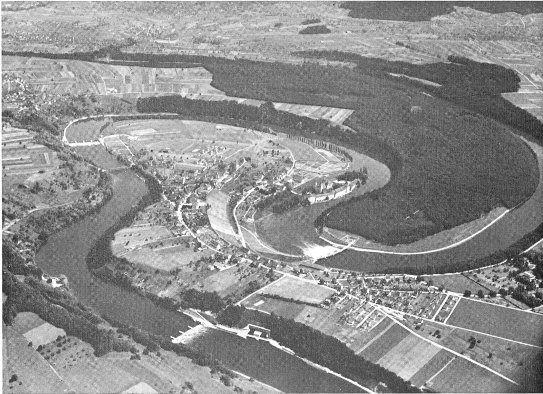
Bild 13 Grenzkraftwerk Rheinau mit Rheinschleife (Inbetriebnahme 1956). Rechts Hauptstauwehr mit Überlauf zur Dotierung der durch die Kraftnutzung abgeschnittenen Rheinschleife (der Auslauf des Unterwasserstollens des Kraftwerkes ist im Vordergrund sichtbar). Die beiden Hilfswehre (links) sorgen für die gewünschte Wasserhaltung im abgeschnittenen Flußarm. (Fliegeraufnahme Swissair AG, Zürich)
