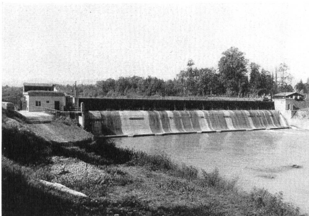
Bild 12 Saalachkraftwerk der Salzburger Stadtwerke in überflutbarer Bauweise mit Rohrturbinen (Inbetriebnahme 1951) a) bei Turbinenbetrieb ohne Überflutung
