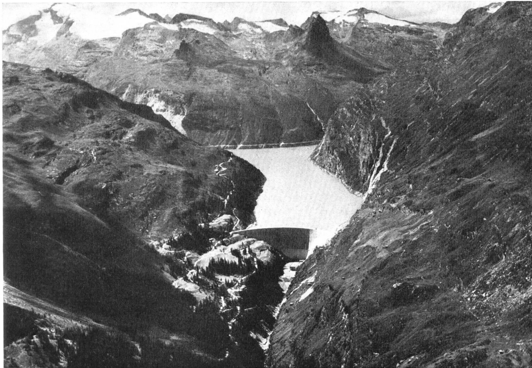
Bild 2 Staumauer und Stausee Zervreila (Aufnahme Photopreß, Zürich)
