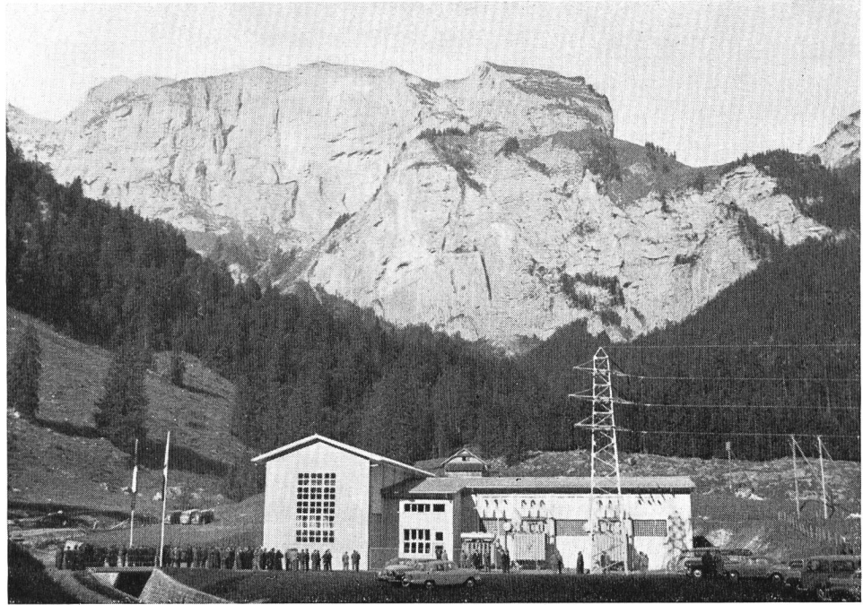
Bild 2 Zentrale Hugschwendi in der Stöckalp; Einweihungsfeier des Kraftwerks Melchsee-Frutt (Photo G. A. Töndury)
