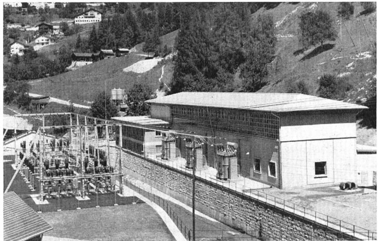
Bild 3 Zentrale Vissoie im Val d'Anniviers, inst. Leistung 45 MW, der mittleren Gefällsstufe Lac de Moiry—Vissoie. Zwischen dem Maschinenhaus und der im Bilde links sichtbaren Freiluftschaltanlage befindet sich das Flußbett der Navisence. Links oben ist ein Teil des Dorfes Vissoie sichtbar; einige Neubauten wurden durch den Kraftwerkbau veranlaßt, nämlich zwei Personelhäuser und das mit finanzieller Unterstützung der Kraftwerkgesellschaft erstellte Krankenhaus der Talschaft. (Photo Beringer und Pampaluchi, Zürich)
