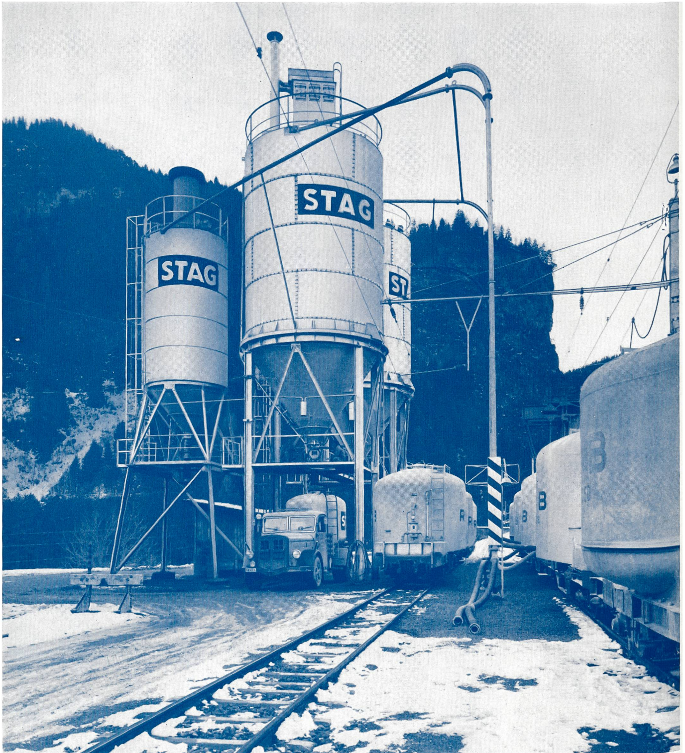
Umschlagsanlage Thuisis der STAG: 2 Umschlagsilos à ca. 200 t für Normalzement 1 Umschlagsilo von ca. 65 t für Spezialzement
