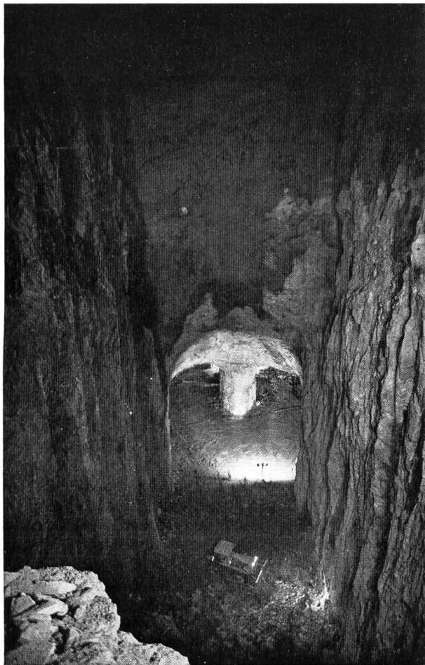
Bild 56 Felsausbruch für ein Saugrohr des Kraftwerks Pirttikoski
