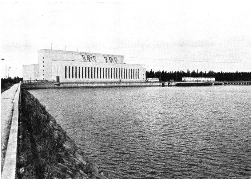
Bild 66 Kraftwerk Pyhäkoski am Oulujoki, vom Oberwasser gesehen
