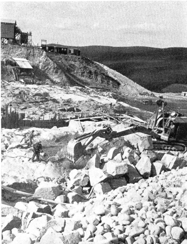
Bild 24 Großer Steingreifer an der Arbeit
