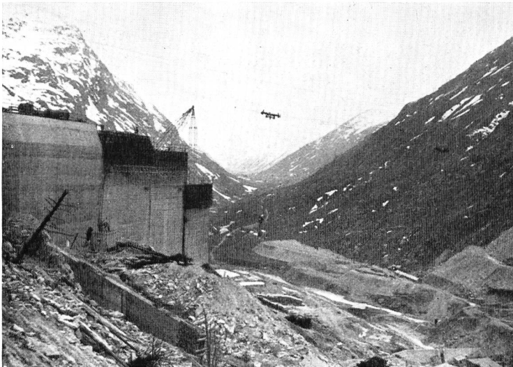
Bild 3 Rechtes Widerlager der Bogenstaumauer, im Talgrund Fundamentbetonierung (Bauzustand 14. Mai 1959)
