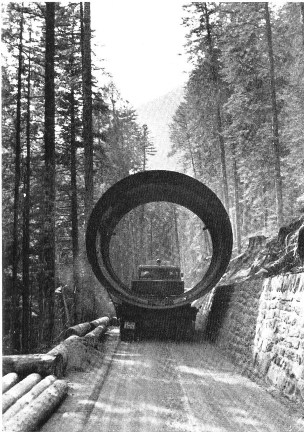
Bild 1 Bergtransport eines Druckrohrs für die Schachtpanzerung der Kraftwerkstufe Bärenburg-Sils
