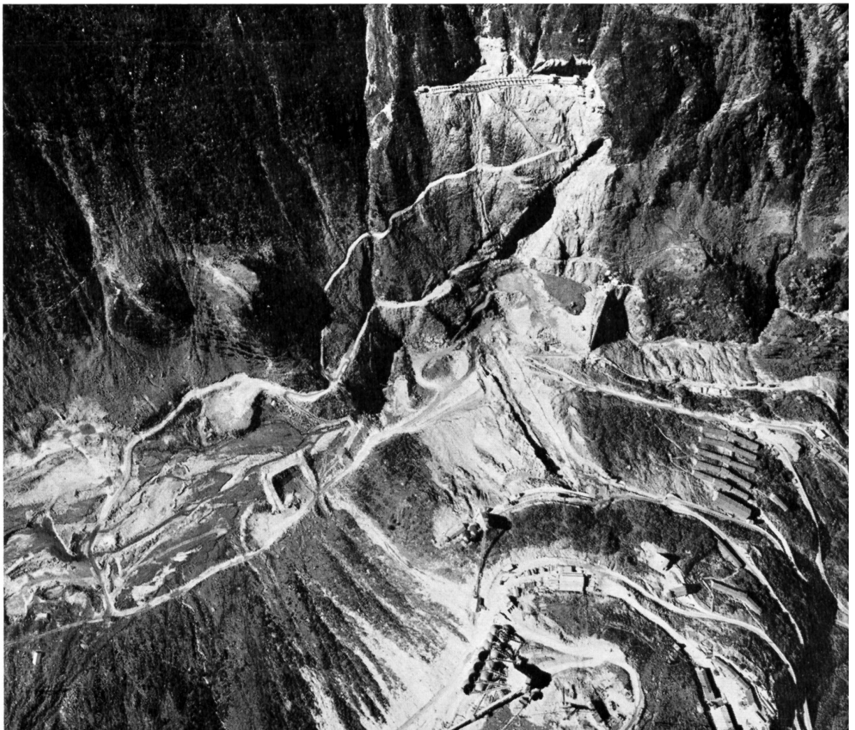
Bild 4 Baugruben Talsperre Val Nalps, aufgenommen mit der Reihenbildkamera Wild RC7a, f = 100 mm, Flughöhe 700 bis 900 m über Boden (Aufnahme: Eidg. Vermessungsdirektion)
