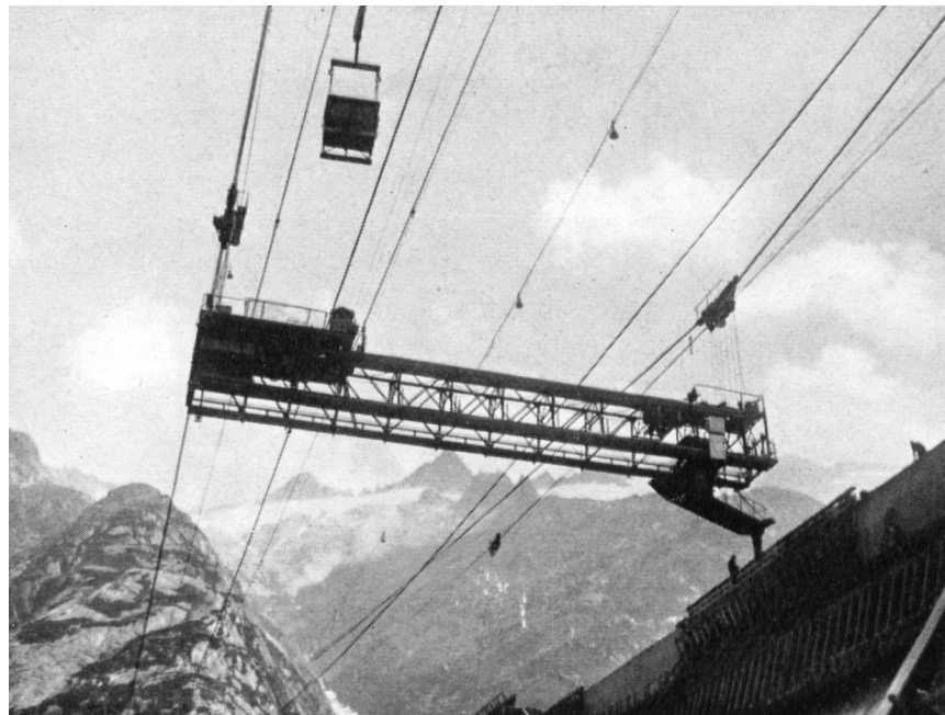
Bild 5 Staumauer Rätherichsboden: fester Kabelkran bedient Betonierbühne in der letzten Betonierphase der Staumauerkrone
