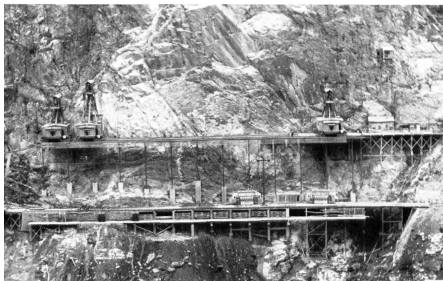
Bild 6 Staumauer Sambuco: parallel fahrbare Krane auf hohen Eisenkonstruktionen; die großen Horizontalkräfte sind auf Höhe der Fahrbahn im Fels verankert. Darunter Betonauflagepodest mit Geleisebetrieb
