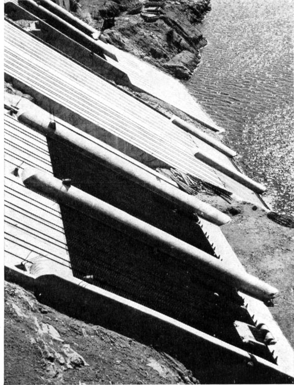
Kraftwerk Kariba (Rhodesien). Rechenreinigungsmaschine mit einer Hublänge für den Hakenwagen von 135 m.
