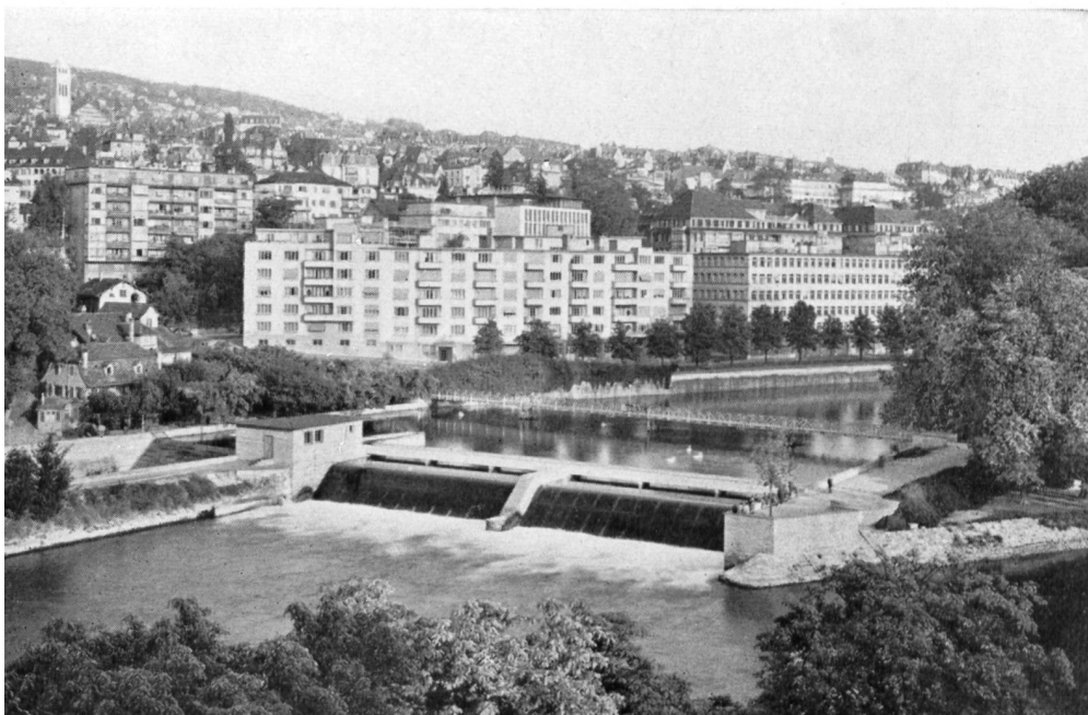
Fig. 6 Earrage-toit, à Zurich (1941)
