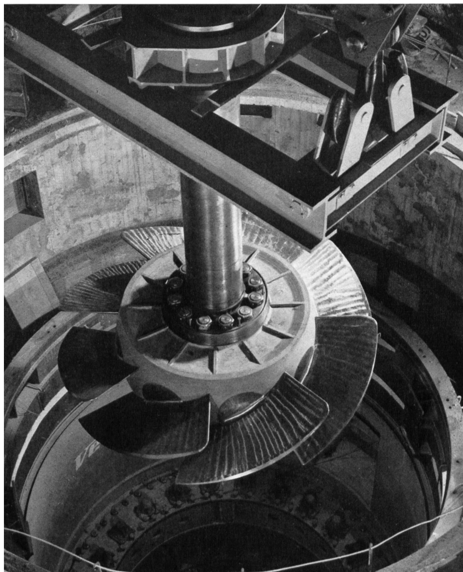
Bild 11 Montage eines 8schauffigen Kaplanrades im Kraftwerk Lavey; 33 650 PS, H 42 m (1948)
