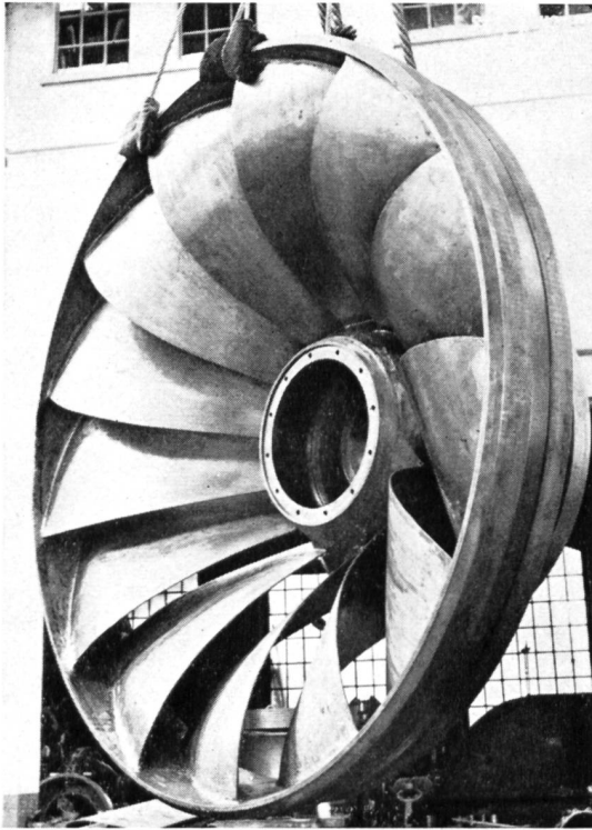
Bild 6 Extreme Francis-Schnellläuferturbine, n_s = 330 , für die Anlage Neuhausen; 6520 PS, Gefälle etwa 21,5 m (1950)
