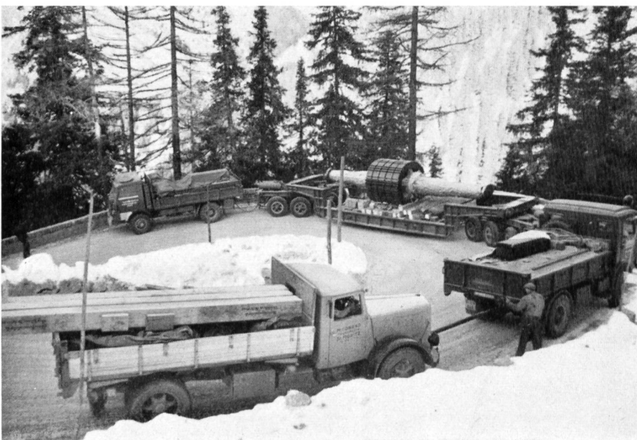
Bild 11 Transport eines 54 Tonnen schweren Rotors von St. Moritz nach der Zentrale Castasegna im Bergell. Langsam überwindet der Schwerlastzug die zahlreichen Kurven des Maloja-Passes; um den Chauffeuren ihre Aufgabe zu erleichtern, sind sie durch Telefon miteinander in ständiger Verbindung.
