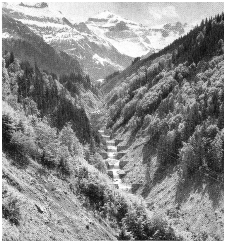
Fig. 9 Vue d'ensemble du cours supérieur du Durnagelbach, corrigé en partie (mai 1960).
