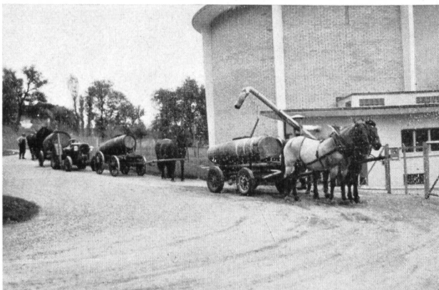
Bild 9 Kläranlage Uster; der Schlamm wird zur landwirtschaftlichen Verwertung abgeholt.
