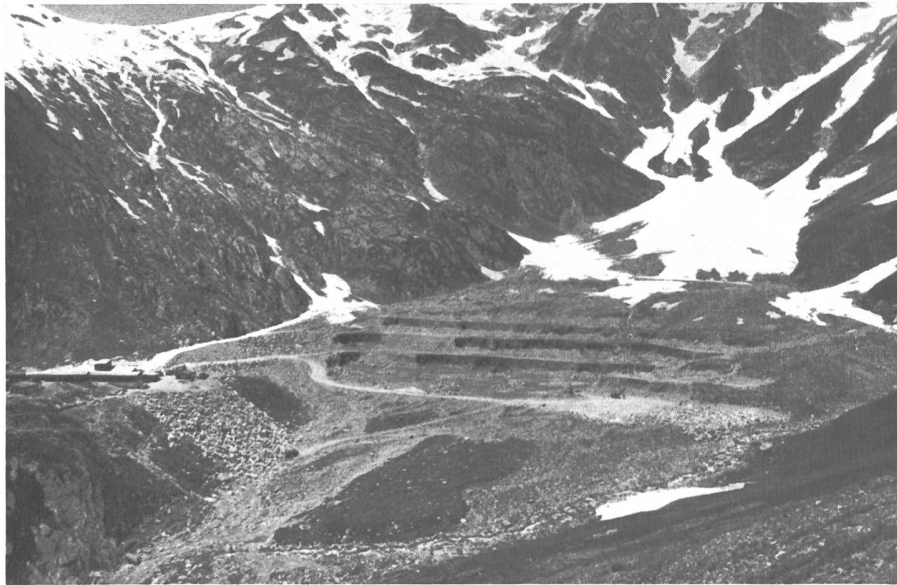
Bild 5 Pian Giaret, Baggerfeld für die Gewinnung der Zuschlagstoffe für den Beton der Staumauer
