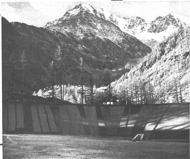
Ausgleichsbecken «Eggen» der Energie Electric du Simplon
