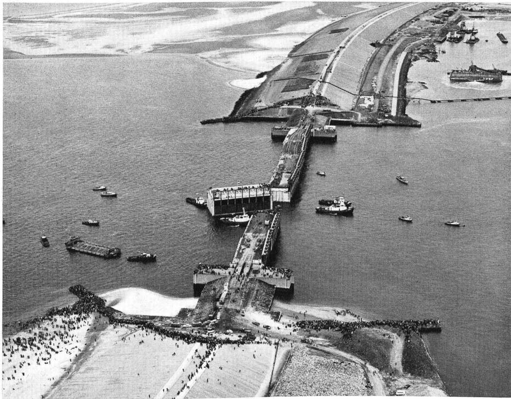
Bild 7 Schließung des ersten Dammes im Rahmen des Deltaplanes am 24. April 1961. Ein Seearm des Veersche Gat wurde mittels sieben Riesen-Beton-Senkkasten abgeriegelt, an beiden Seiten dieser Verschließung wurden 3 Mio m 3 Sand gespült; im November 1961 war dieser Damm, mit Asphaltbeton abgedeckt, vollständig fertig.
