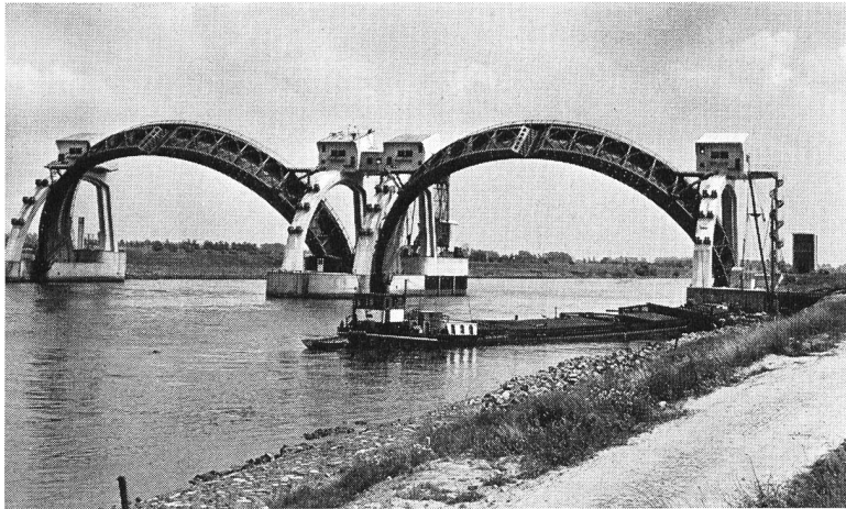
Bild 5 Der Wasserhaushalt Hollands wird zusehends verbessert. Zur Behebung des drohenden Süßwassermangels werden drei Stauwerke gebaut, das erste südlich von Utrecht ist fertig erstellt; bemerkenswert ist die Formgebung dieses beweglichen Stauwerkes.
