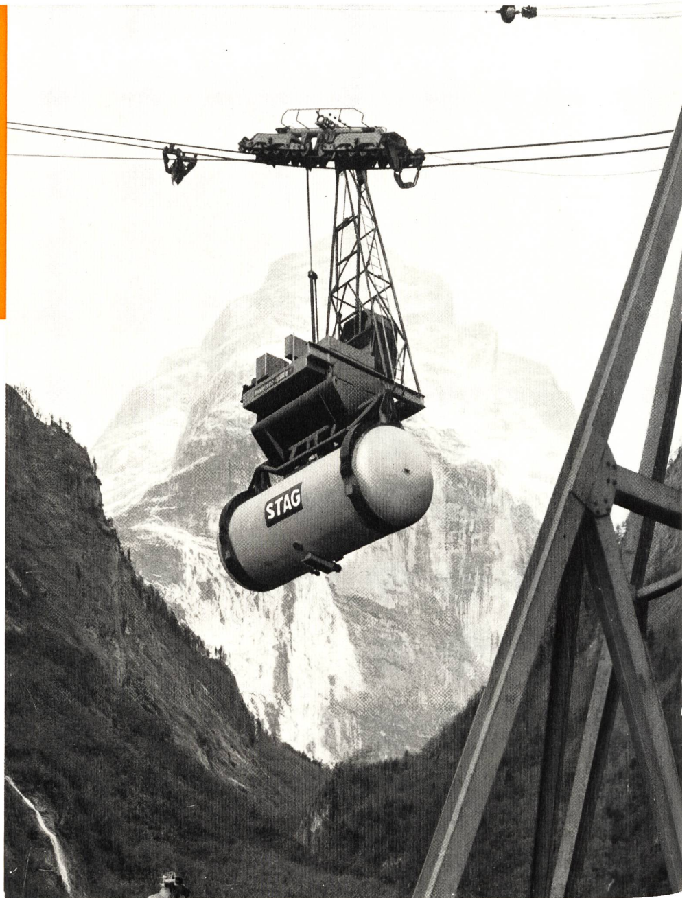
Schwerseilbahn der Kraftwerke Linth-Limmern AG STAG-Behälter von 16 t Fassungsvermögen für Zement
