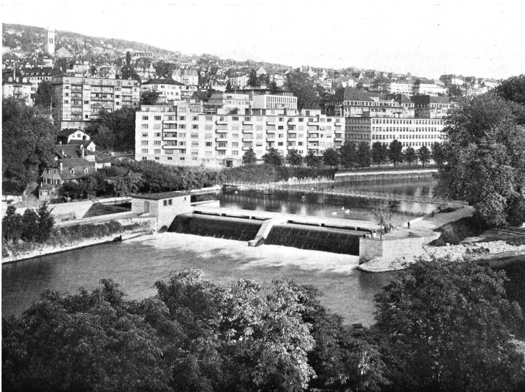
Bild 2 Dachwehr für die Regulierung des Zürichsees
