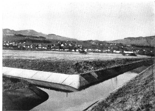
Bild 4 Einmündung des Entensekanals in den Gastergraben bei Uznach
