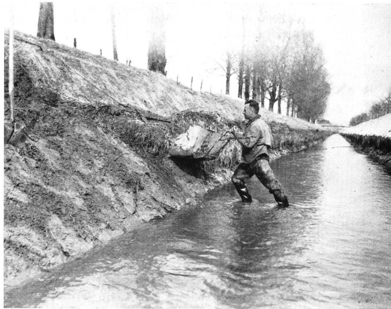
Bild 7 Abtrag verwachsener Böschungen mit Seilzug-Schleppschaukel im Rufibach
