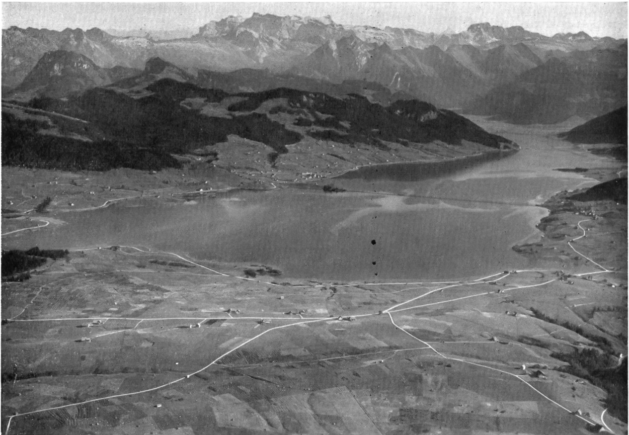
Bild 4 Der große, unweit Einsiedeln geschaffene Sihlsee, Speicheranlage des Etzelkraftwerkes
