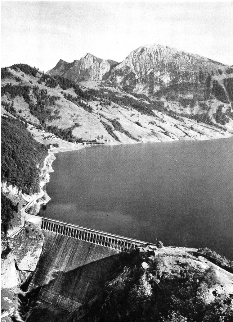
Bild 2 Staumauer Schräh mit Speichersee Wägital, der wichtigsten Anlage der Kraftwerkgruppe Wägital-Rempen-Siebenen; Aufnahme vom 7. Oktober 1938
