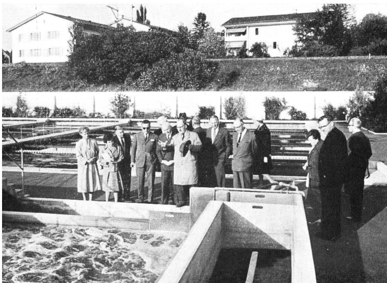
Erläuterungen bei der Gemeinschaftskläranlage von Künsnacht-Erlenbach
