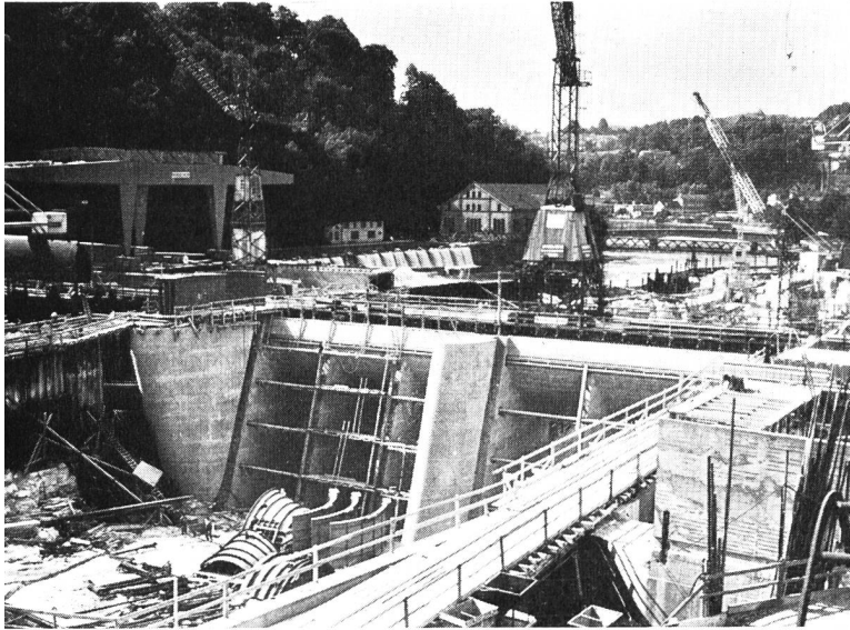
Überblick auf die Baustelle für das neue Rheinkraftwerk Schaffhausen
