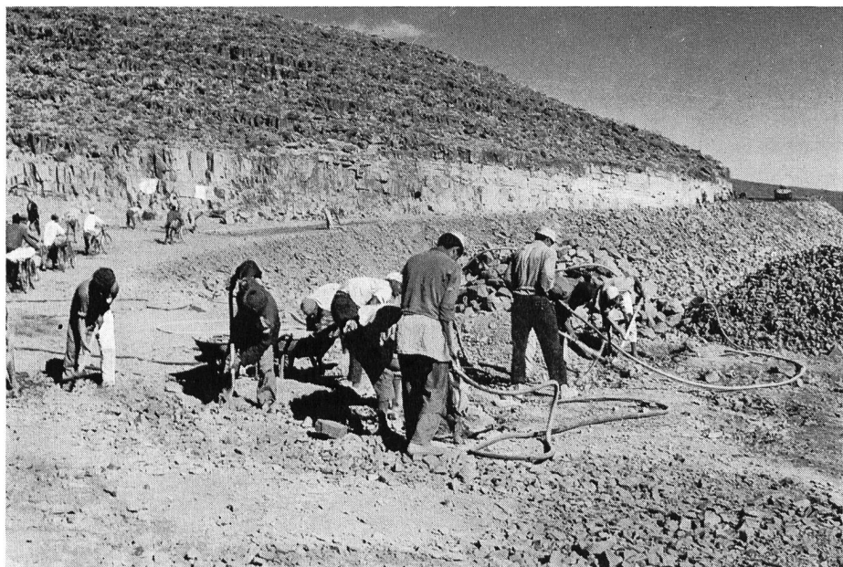
Fig. 38 Moderner Straßenbau in den Fels- und Steinwüsten Südmarokkos auf der Strecke Ouarzazate—Agdz im Draatal Route moderne dans le désert de pierres du sud marocain, entre Ouarzazate et Agdz, dans la vallée du Draa
