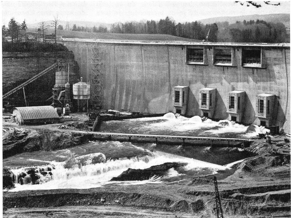
exercées par les consoles. Des injections d'étanchéité et de consolidation ont aussi été exécutées dans la molasse marine des appuis latéraux, mais les absorptions de ciment et même de gels de silicate de soude ont été pratiquement nulles, ce qui a confirmé l'absence de fissurations.
