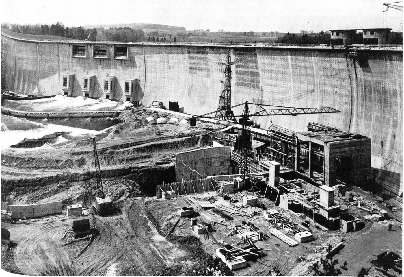
Fig. 4 Vue de l'aval. Au premier plan à droite la centrale en construction.
