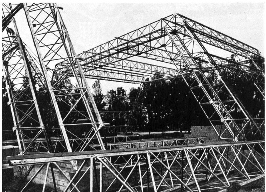
Fig. 3 Der Sektor 4 «Industrie und Gewerbe» mit seinen dreidimensionalen Strukturen aus Stahlrohr von grosser Spannweite, die sich wie grosse Meccanoteile zusammensetzen lassen und fächerförmig um einen Platz angeordnet sind. (Aufnahme vom 24. Mai 1963)
