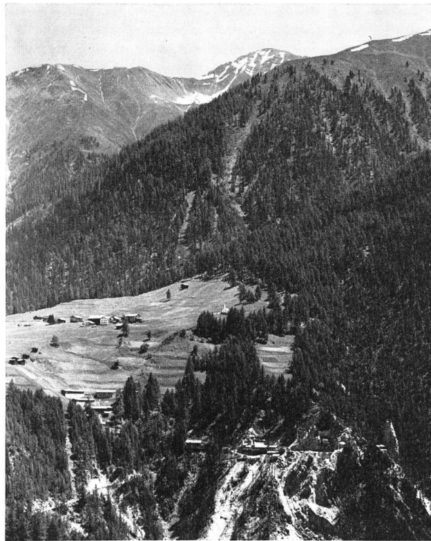
Fig. 9 Maiensäss Jenisberg und Baustelleninstallationen des Fensters Jenisberg
