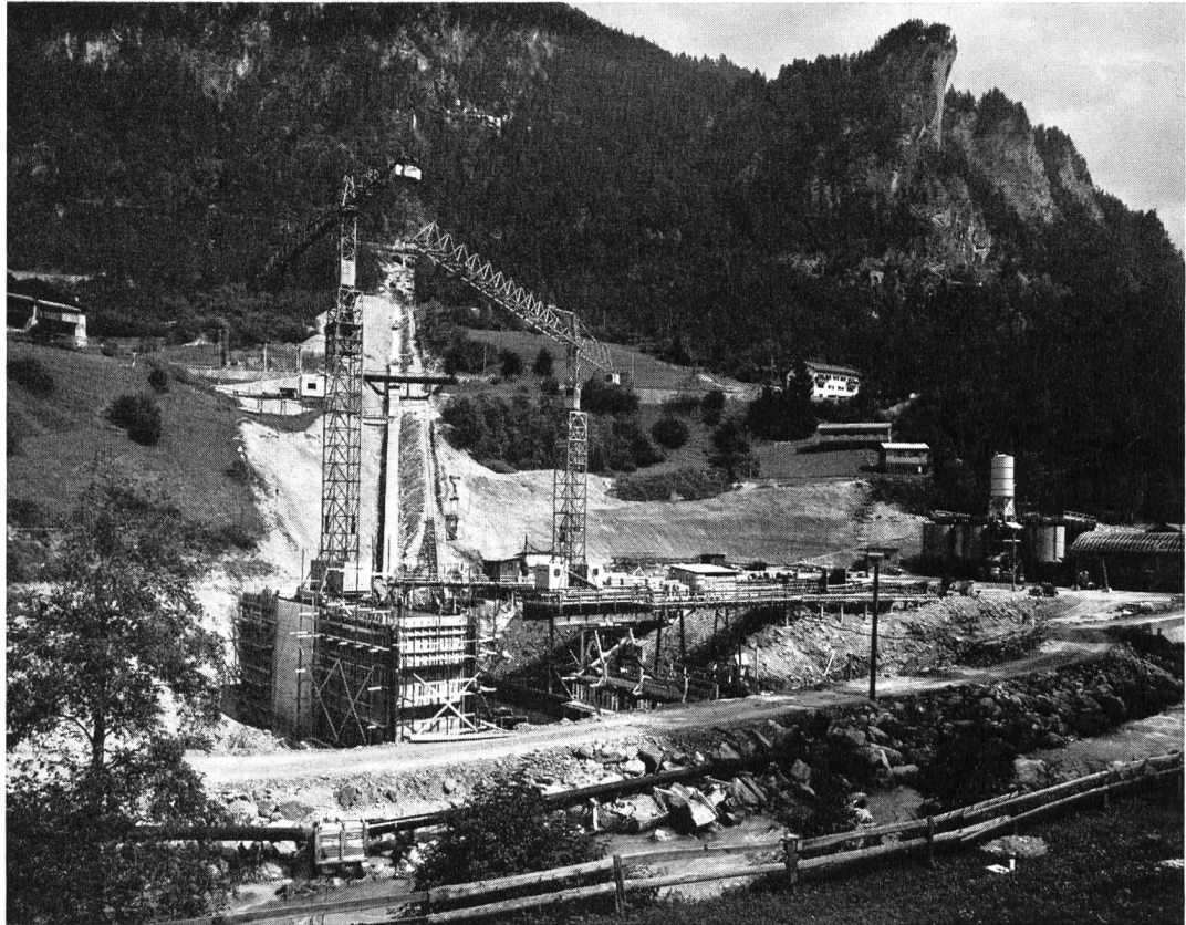
Fig. 15 Uebersicht der Baustelle der Zentrale Filisur und der Druckleitung
