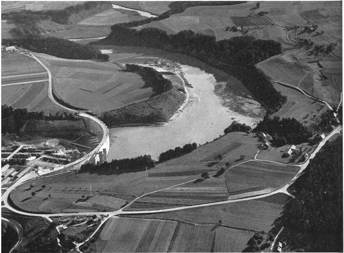
Fig. 18 Luftaufnahme der Talsperre Schiffenen der Entreprises Electriques Fribourgeoises an der Saane; das Maschinenhaus steht am linksseitigen Fuss der Bogenmauer, über deren 417 m lange Krone die neue Strasse führt; der zukünftige Stausee reicht auf seiner Länge von 13,5 km bis in die Gegend der Stadt Freiburg.
